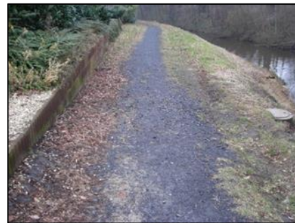
Abb. 77: Fußweg am Mühlenbach, westlich der Mühlenstraße
