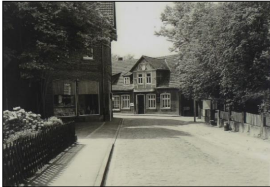
Abb. 7: Blick auf die Dorfstraße
