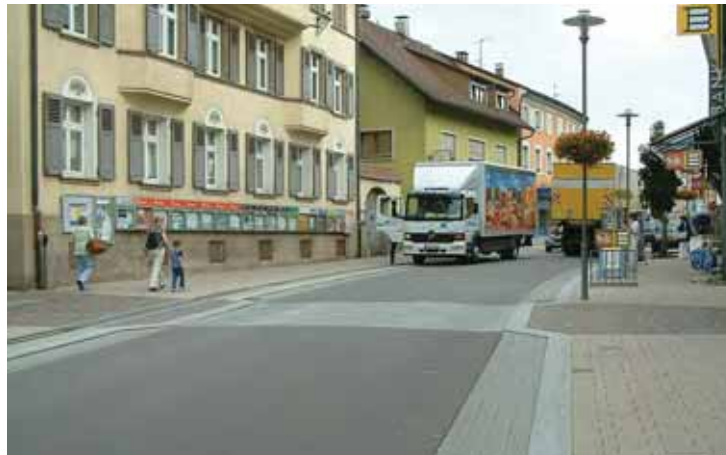
Abbildung 52: Vorgezogener Seitenraum in Wehr [DVR 2019a]
