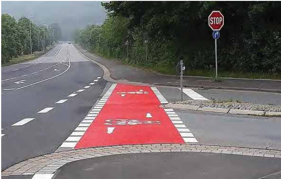
Abbildung 56: Radfahrerfurt an einer einmündenden Straße [ADFC Hildesheim 2018]
